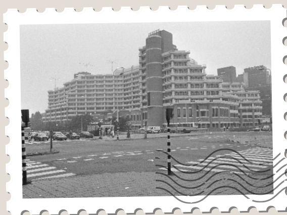
Het voormalig Ministerie van Buitenlandse Zaken, de 'Apenrots' (foto: Wikimedia Commons)
